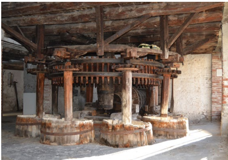
Fig. 16 – Mulino di Nove. L'impianto ligneo a sud per la frantumazione e la macinazione delle fritte.
