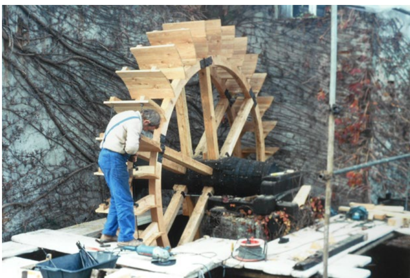
Fig. 20 – Il mastro carpentiere Sepp Tauber completa il montaggio della ruota dell'impianto sud del mulino di Nove (1992).
