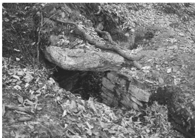
Fig. 4 - Der Winkeleingang vom Rätischen Haus vor Grabungsbeginn.
