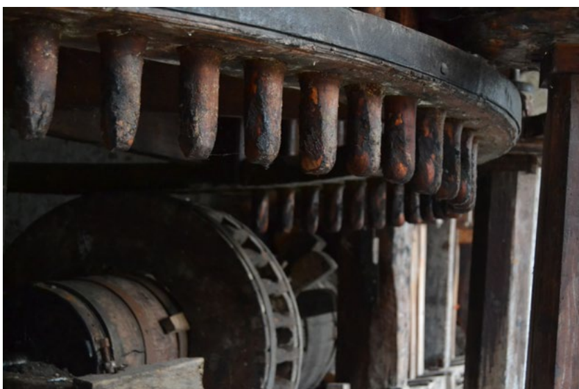
Fig. 23 – Mulino di Nove. I denti della grande ruota orizzontale, spinti dai pioli della lanterna.
