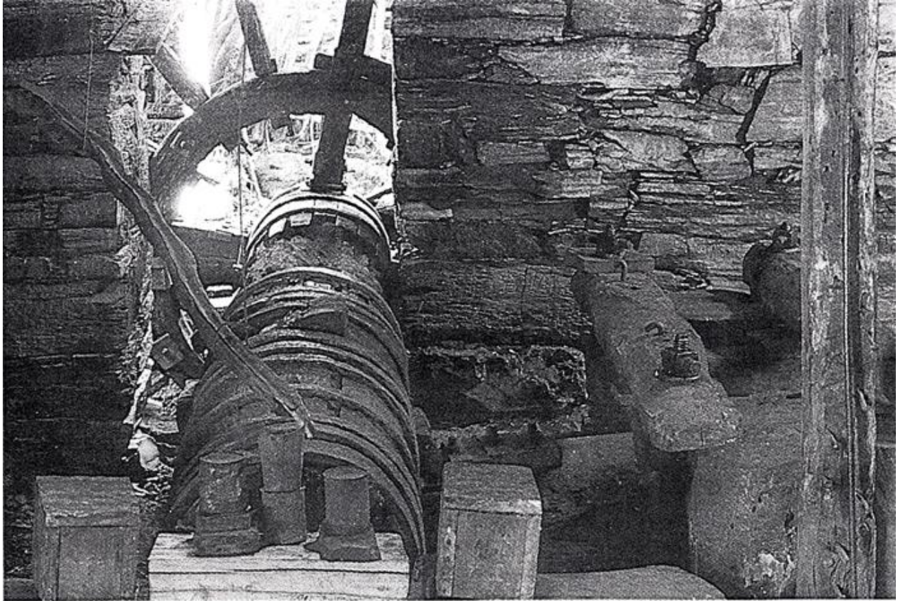
Rueda hidráulica y eje motor en el martinete de Compludo (León).
